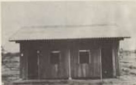
14 — Xây dựng lên để làm thủ-thành-sa Thủ-Thành-sa và Thủ-Thành-sa Bắc-Việt.
