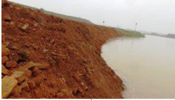
Khai thác cát sỏi trên sông Cầu gây sạt lở đê ở xã Quế Tân
