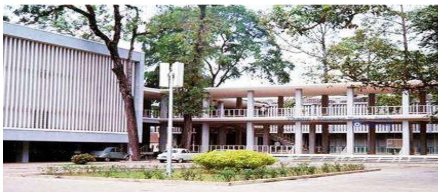
Hình 8c,d: Trung Tâm Giáo Dục Y Khoa trên đường Hồng Bàng, Chợ Lớn hoàn tất 3 năm sau (giai đoạn I), việc xây dựng một Bệnh viện Thực Tập hiện đại (giai đoạn II) phải ngưng vì những biến động chính trị cho tới 1975. [nguồn: internet]
